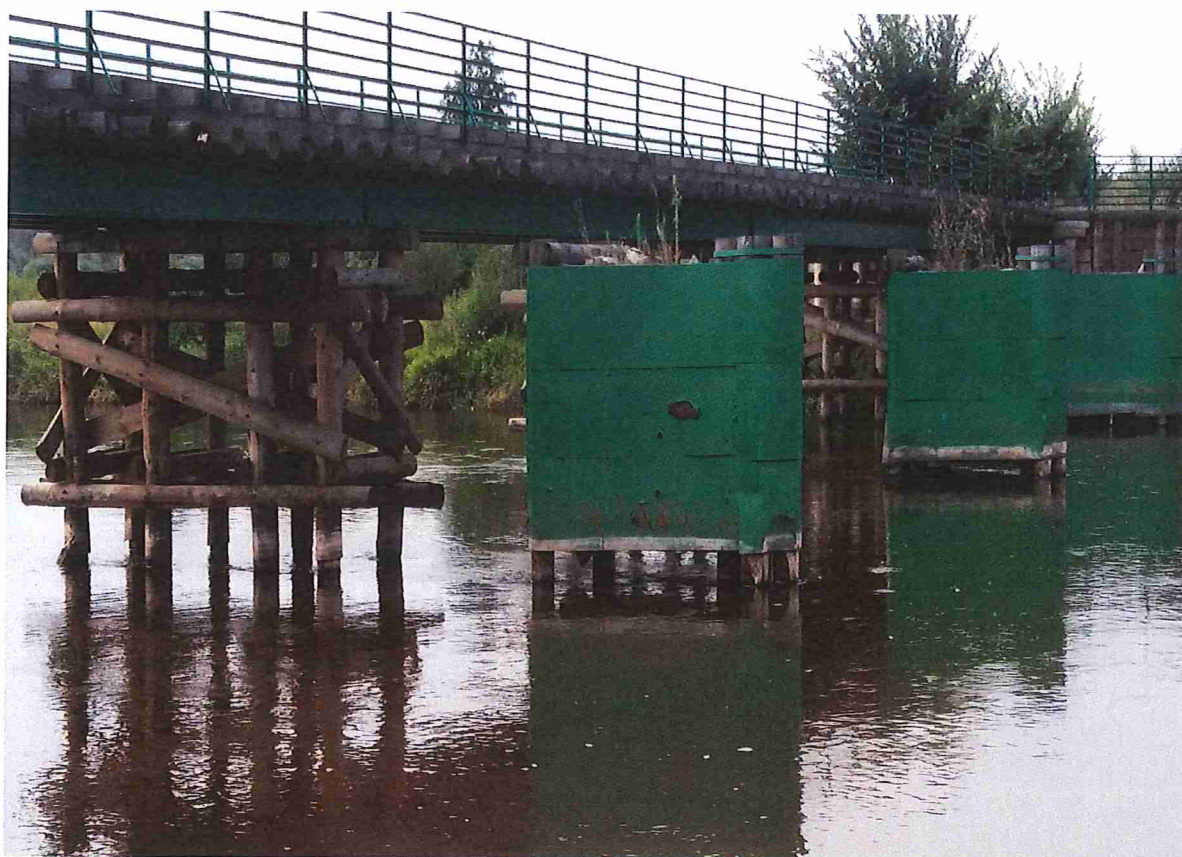
Fot.1 Konstrukcja mostu drewnianego ( sprawdzenie izbic )
