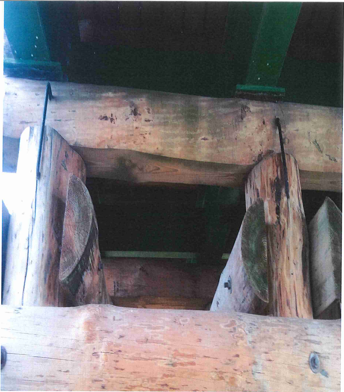
Fot.3 Sprawdzenie łożysk , stan dobry
