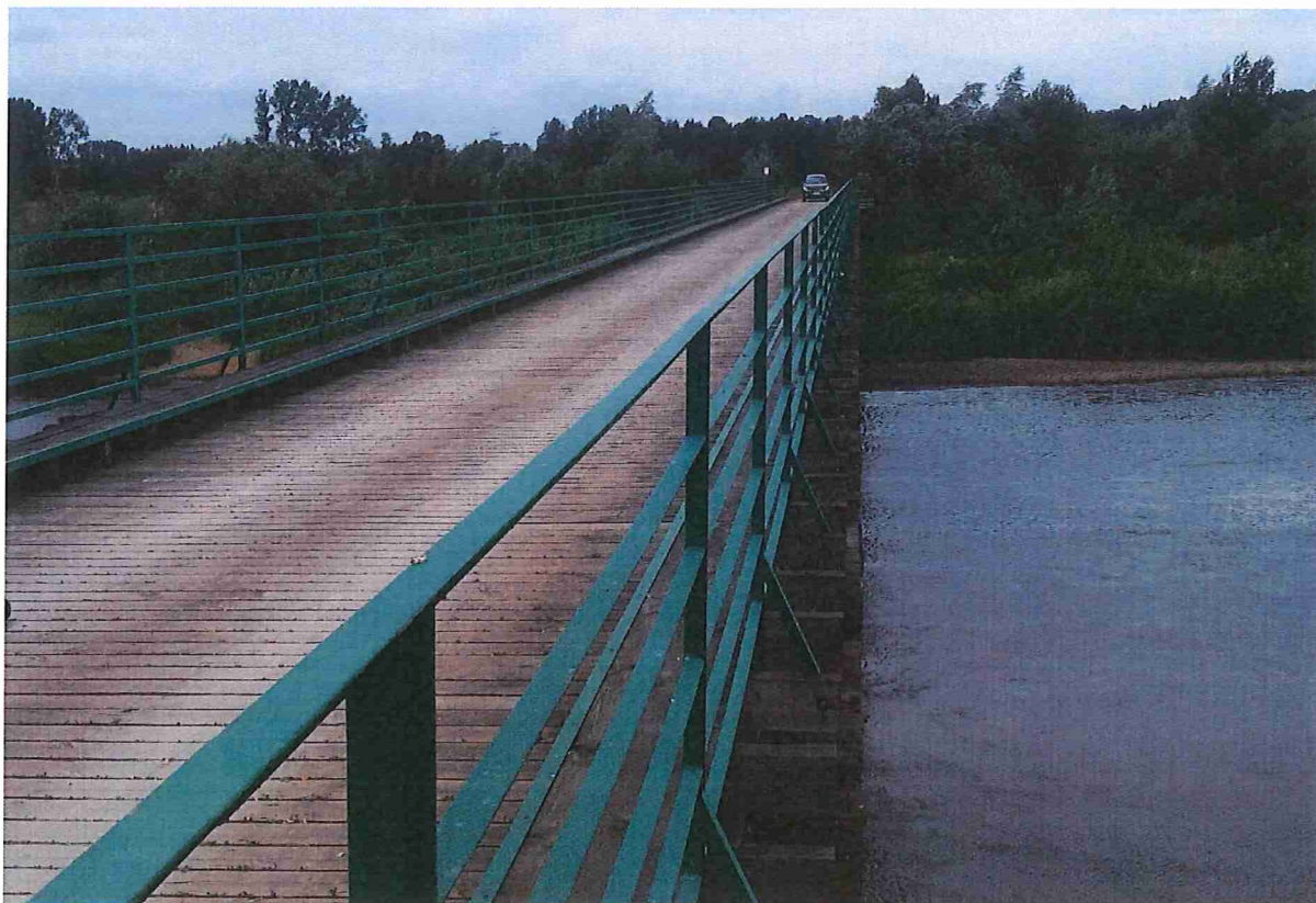
Fot.7 Pomost drewniany z bariera metalową( widok )
