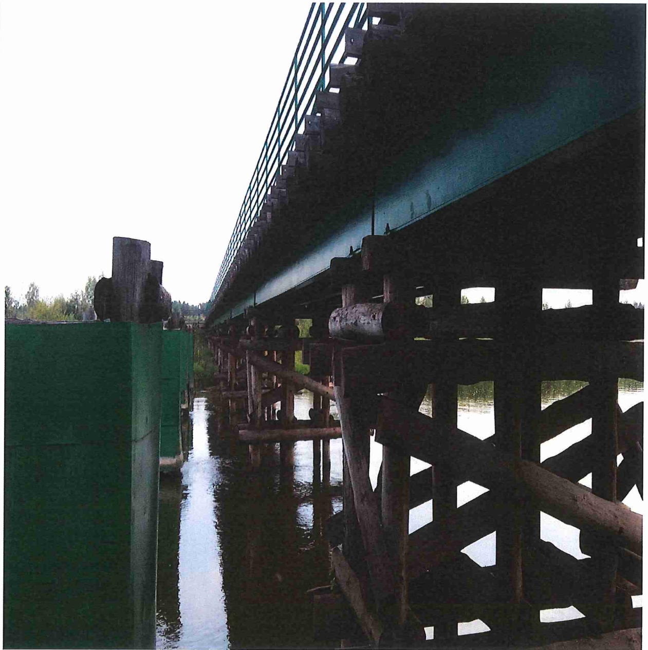
Fot.2 Konstrukcja mostu drewnianego ,podpory (widok )
