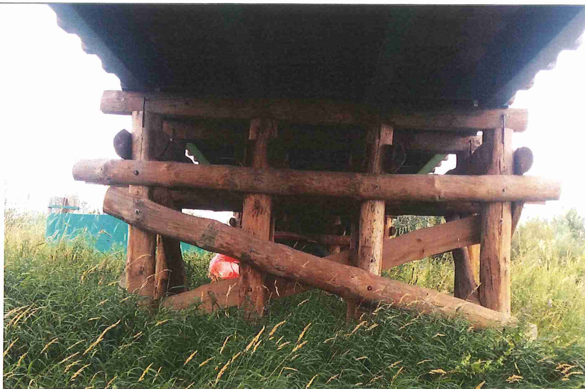
Fot.5 Konstrukcja podory stan dobry ( sprawdzenie łożysk )
